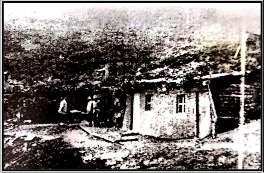
Görsel: 16'ncı Kolordu Komutanlığı'nın Turşunköy'deki Karargâh Binası 99
