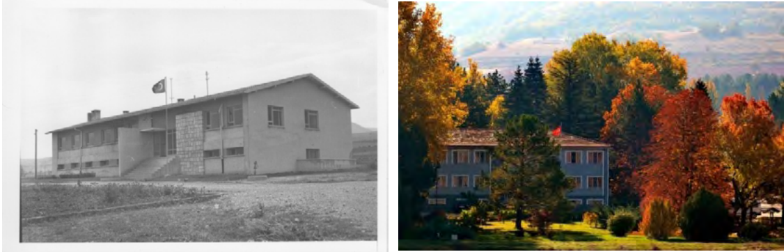
Tokat Bölge Sulu Ziraat Deneme İstasyonu İdare Binası.
