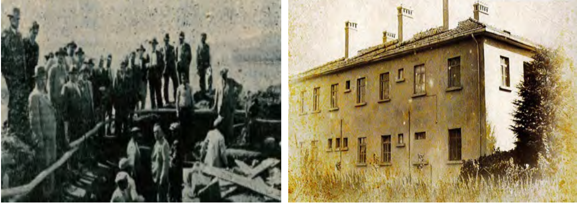
Gaziantep Fıstık Araştırma İstasyonu temel atma töreni ve İstasyon binası.
