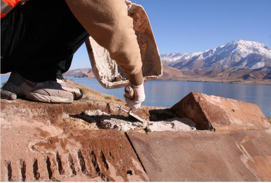
Görsel 7- Kireç harcı ile eksik taşların yerlerine yerleştirilmesi
