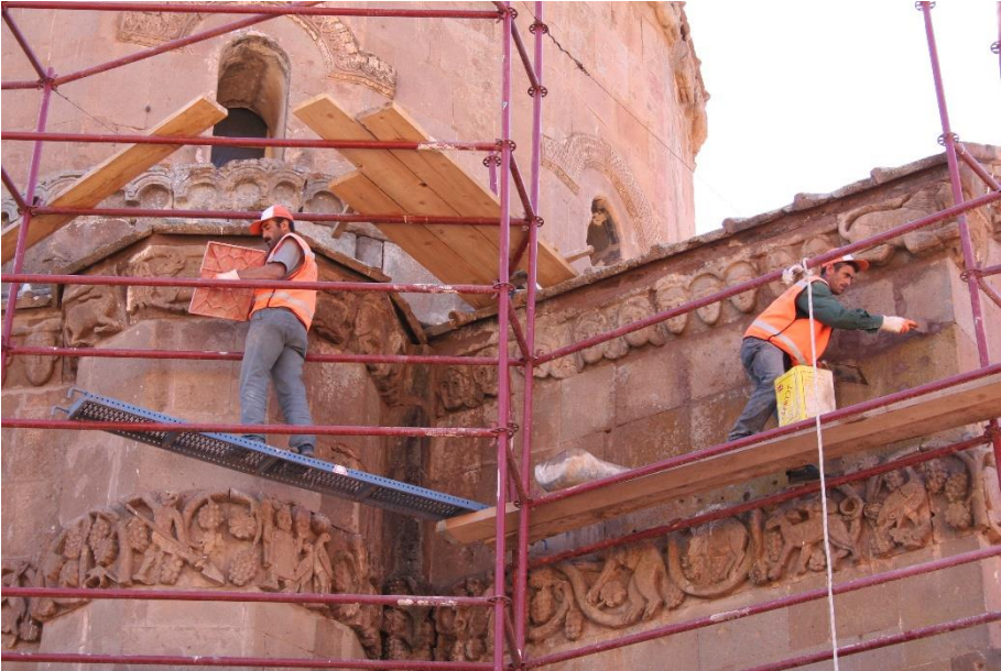
Görsel 8- Kireç harcı ile derz dolgularının yapılması
