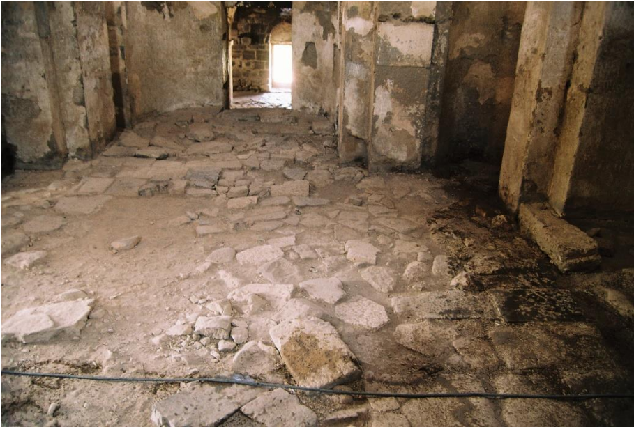
Görsel 4-Restorasyon öncesi kilise içindeki taban döşemeleri
