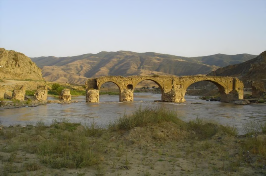
Fotoğraf 3. Hudaferin Köprüsü 2 (Sımk Köprü)
